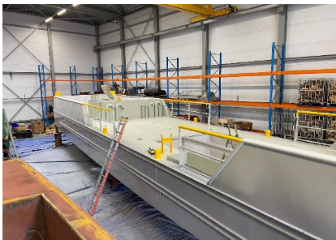
Afbouw van het werkschip op de scheepswerf van Groeneveldt Marine Construction in Hendrik-Ido-Ambacht
